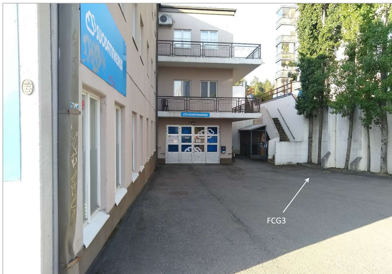
Kuva 6. Kiinteistön länsipuoli Sammonkadulta katsottuna. Alueella kulkee viemäröintejä ja kaapeleita. Kiinteistön reunalla sijaitsevat portaat vievät Takojankadun puoleisessa päädyssä sijaitsevalle yläpihalle.
