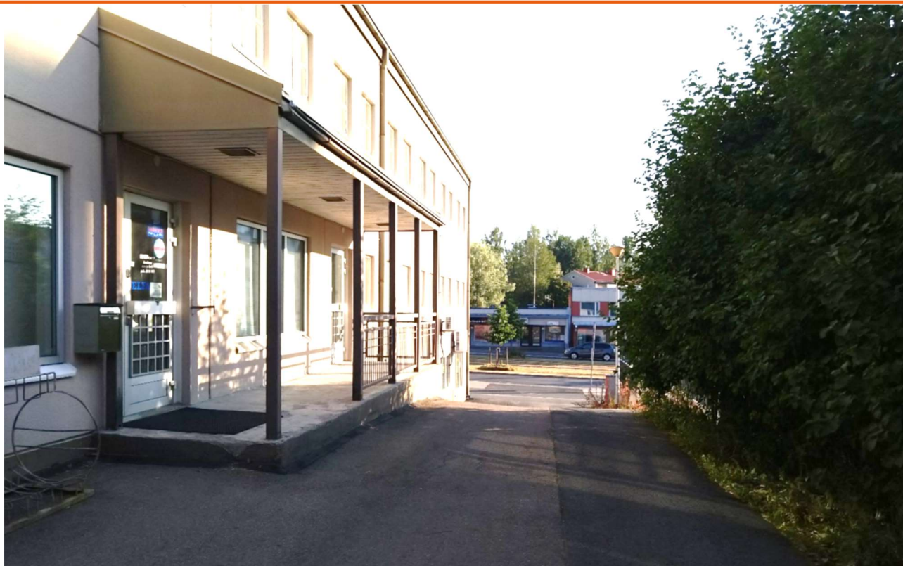
Kuva 3. Kiinteistön itäpuoli alamäkeen kohti Sammonkatua. Kuva on otettu mm. elektroniikkatarvikkeita myyvän Elektorin liiketilan edustalta. Tutkimuspiste FCG2 sijaitsee katoksen pohjoisreunan kohdalla.
