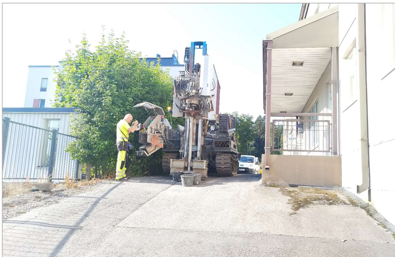
Kuva 4. Tutkimuspisteen FCG2 sijainti. Kairapisteesen asennettiin näytteenoton jälkeen huokoskaasuputki.
